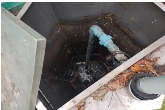
IMAGEN 32 MANTENCIÓN, LIMPIEZA Y PUESTA EN MARCHA EN P.T.A.S
