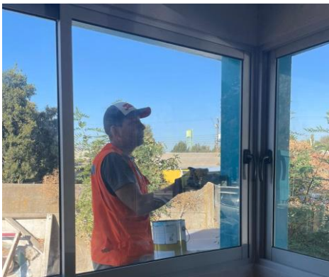
IMAGEN 53 CAMBIO DE VENTANAS EN SALA PIE, ESCUELA COMALLE
