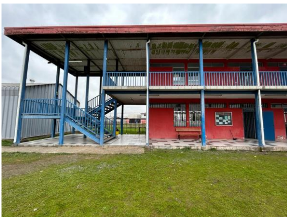
IMAGEN 31 MANTENCIÓN DE CANALETAS LICEO TENO
