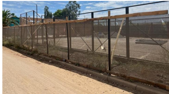
IMAGEN 69 MULTIESPACIO DEPORTIVO NUEVA BELLAVISTA
