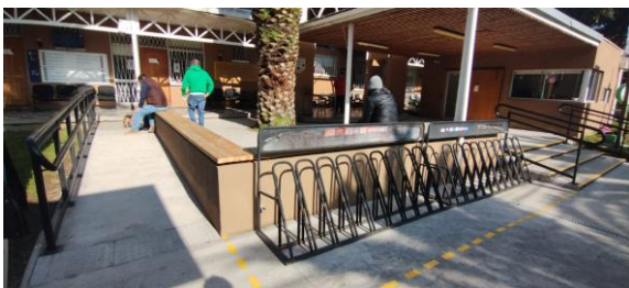
IMAGEN 7 MEJORAMIENTO INTEGRAL EDIFICIO CONSISTORIAL
