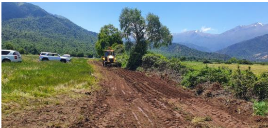
IMAGEN 89 LIMPIEZA DE CAMINO CON RETROESCAVADORA EL MANZANO
