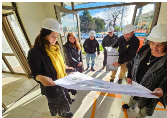
IMAGEN 12 REHABILITACIÓN JUZGADO DE POLICIA LOCAL
