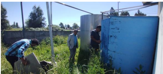
IMAGEN 40 MANTENCIÓN, REPARACIÓN Y PUESTA EN MARCHA P.T.A.S
