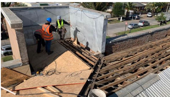
IMAGEN 6 MEJORAMIENTO INTEGRAL EDIFICIO CONSISTORIAL
