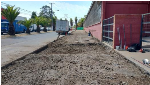
IMAGEN 2 MEJORAMIENTO VEREDA SUR AVDA. DR FAUNDEZ.
