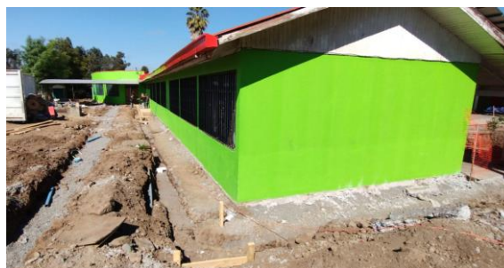
IMAGEN 37 MEJORAMIENTO CUBIERTA ESCUELA SAN CRISTÓBAL.
