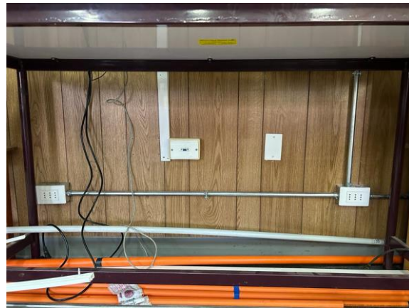
IMAGEN 54 REPARACIÓN ELÉCTRICA ESCUELA HUEMUL.
