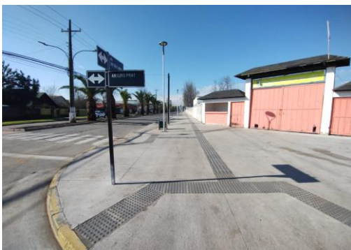
IMAGEN 3 MEJORAMIENTO VEREDA SUR AVDA. DR FAUNDEZ
