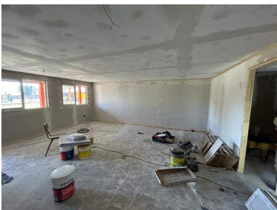
IMAGEN 48 MEJORAMIENTO INTEGRAL ESCUELA LAS LIRAS.
