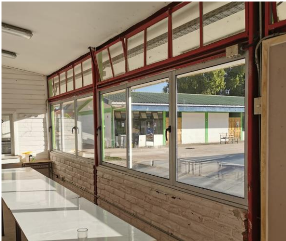
IMAGEN 28 CAMBIO DE PUERTAS Y VENTANAS ESCUELA LAS ARBOLEDAS.
