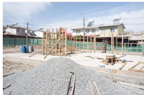
IMAGEN 4 CONSTRUCCIÓN SEDE DON SEBASTIAN
