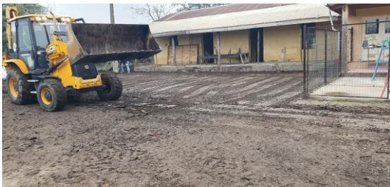
IMAGEN 88 SERVICIO RETROESCAVADORA EN ESCUELA LOS ALISOS
