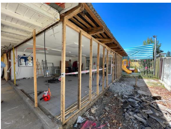
IMAGEN 49 MEJORAMIENTO INTEGRAL ESCUELA LAS LIRAS.
