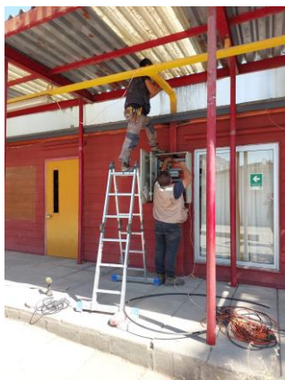
IMAGEN 24 INSTALACIÓN ELÉCTRICA ESCUELA EL GUIINDO.
