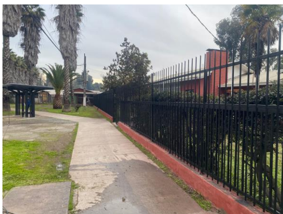
IMAGEN 57 MANTENCIÓN CIERRE PERIMETRAL ESCUELA TENO.
