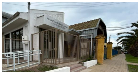
IMAGEN 13 REHABILITACIÓN JUZGADO DE POLICIA LOCAL
