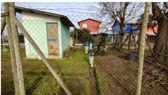
IMAGEN 10 OBRAS MEJORAMIENTO APR'S HACIENDA DE TENO, VILLA COMALLE Y LAS LIRAS.
