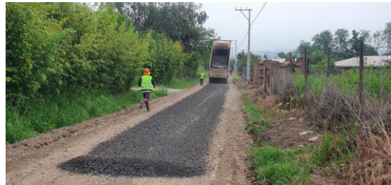
IMAGEN 90 TRANSPORTE DE MATERIAL CAMIÓN TOLVA
