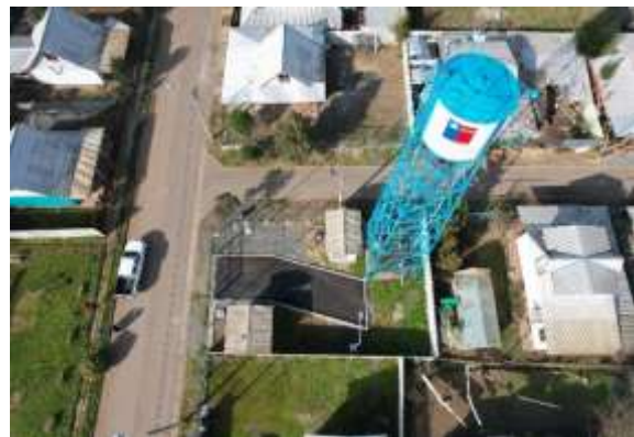
IMAGEN 2 MEJORAMIENTO DE POZO PROFUNDOS APR ENTRELLA DE HUEMUL
