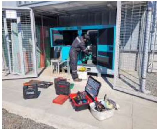
IMAGEN 183 MANTENCION DE EQUIPO ELECTRÓGENO POLIDEPORTIVO TENO.
