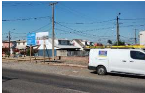
IMAGEN 11 POBLACIÓN DON SEBASTIÁN INSTALACIÓN DE CÁMARA
