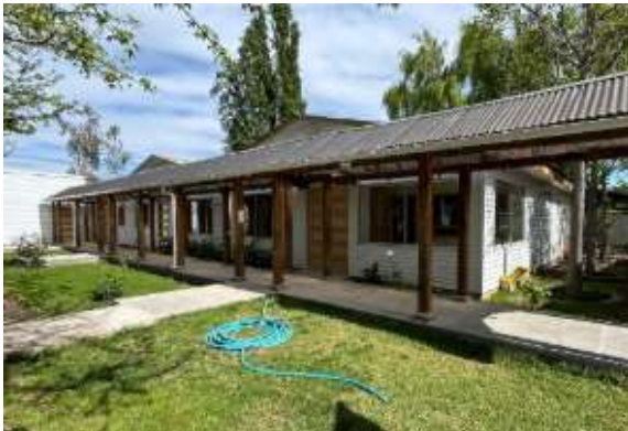
IMAGEN 6 CONSTRUCCIÓN OFICINAS DE DIDECO
