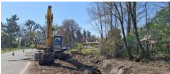
IMAGEN 85 SERVICIO RETROESCAVADORA EN MORZA BAJO
