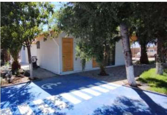
IMAGEN 4 CONSTRUCCIÓN CENTRO COMUNITARIO BARRIO NUEVA BELLAVISTAS
