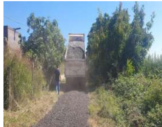
IMAGEN 86 TRANSPORTE DE MATERIAL CAMIÓN TOLVA
