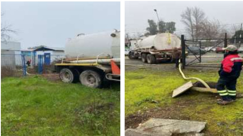
IMAGEN 22 LABORES DE EXTRACCIÓN DE LA P.T.A.S. DE ESCUELA COMALLE.
