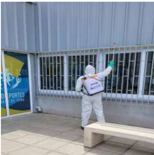
IMAGEN 183 PROCESO DE FUMIGACIÓN, CONTROL DE PLAGAS, SANITIZACION POLIDEPORTIVO.
