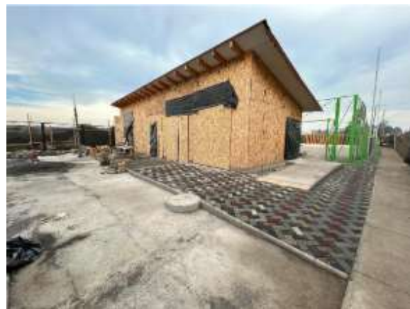
IMAGEN 5 CONSTRUCCIÓN MULTI-ESPACIO DEPORTIVO BARRIO NUEVA BELLAVISTAS
