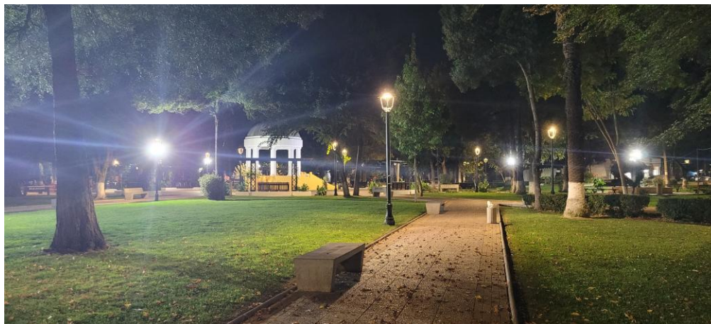
IMAGEN 65 MANTENCIÓN DE LUMINARIAS.
