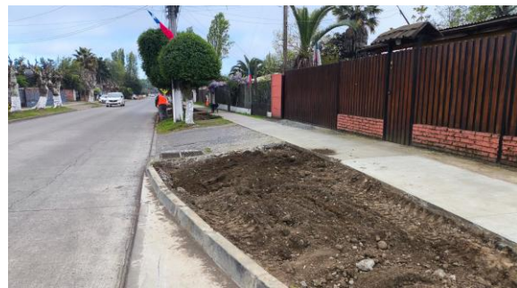
IMAGEN 19 PREVIO A TRABAJOS AVENIDA BELLAVISTA.
