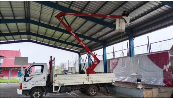
IMAGEN 34 INSTALACIÓN DE LUMINARIAS.
