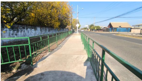
IMAGEN 13 CONTRUCCIÓN VEREDA NORTE AVENIDA COMALLE.
