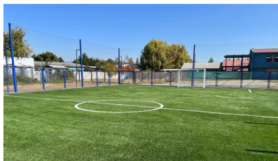
IMAGEN 25 ESPACIO DE PORTIVO, COMALLE.
