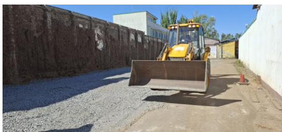
IMAGEN 60 RETROESCAVADORA EN TERRENO.
