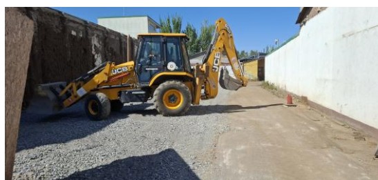
IMAGEN 62 RETROESCAVADORA EN TERRENO.
