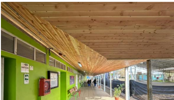
IMAGEN 23 REPARACIÓN DE CUBIERTA
