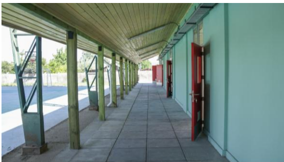
IMAGEN 27 CONSERVACIÓN ESCUELA MONTERILLA.
