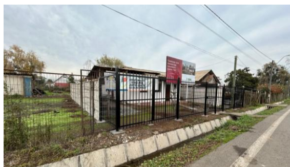
IMAGEN 7 CIERRE PERIMETRAL, SEDE COMUNITARIA EL QUELEMEN.
