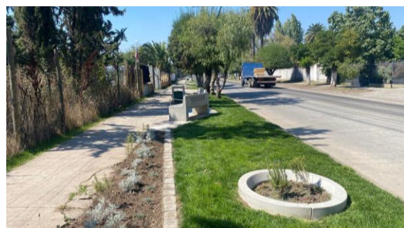
IMAGEN 20 AVANCE TRABAJOS AVENIDA BELLAVISTA.
