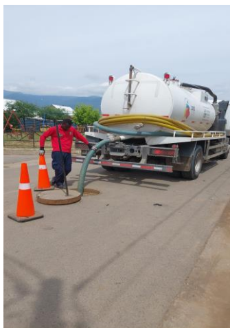
IMAGEN 26 TRABAJO DEL CAMIÓN LIMPIAFOSAS
