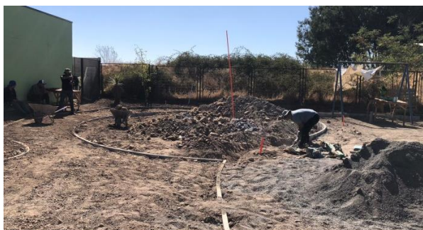
IMAGEN 45 PLAZA DIAGONAL INICIO DE OBRAS .
