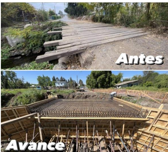
IMAGEN 4 EJECUCIÓN OBRAS EL QUELMÉN
