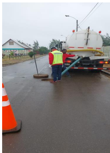
IMAGEN 27 TRABAJOS DE CAMIÓN LIMPIAFOSAS
