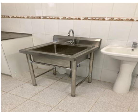
IMAGEN 19 INSTALACIÓN LAVAFONDOS JARDÍN INFANTIL ESPIGUITA.
