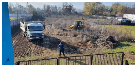
IMAGEN 87 LIMPIEZA DE CAMIÓN TOLVA
