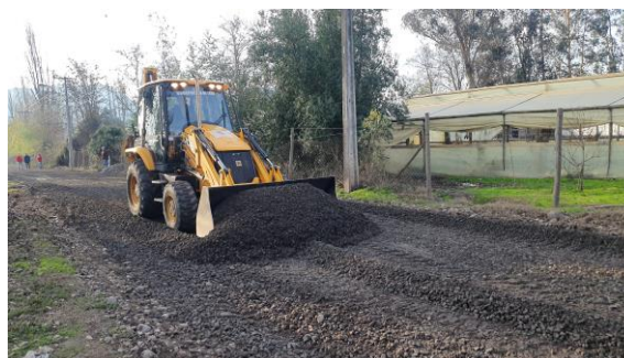
IMAGEN 84 SERVICIO RETROEXCAVADORA EN CAMINO
