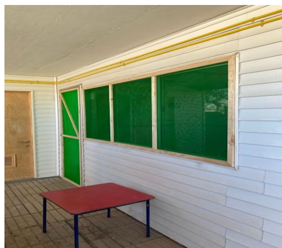
IMAGEN 20 INSTALACIÓN MALLA MOSQUITERA JARDÍN INFANTIL CUNCUNITA.
