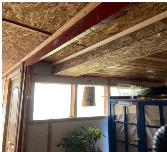
IMAGEN 22 REPARACIÓN DE CANALETA DE AGUA LLUVIA EN BODEGA ESCUELA PRESIDENTE CARLOS IBAÑEZ DEL CAMPO.
