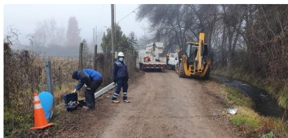
IMAGEN 85 LIMPIEZA DE CAMINO CON RETROEXCAVADORA
