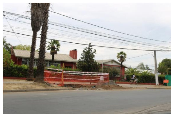
IMAGEN 13 OBRAS EN PARADERO UBICADO EN AVENIDA LAUTARO
